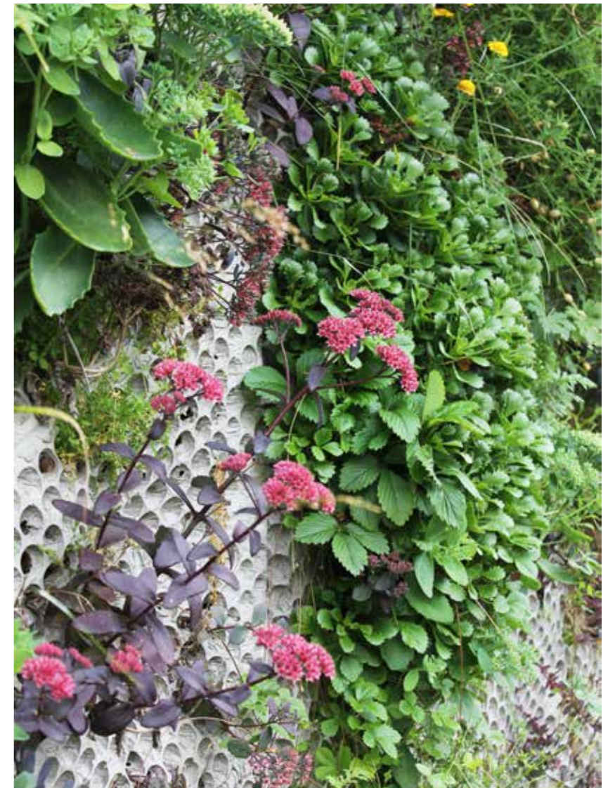
Väggen består av gjutna betongskivor med många små hål. Skivorna släpper igenom ljus och har en tillsats som bryter ned kväveoxid.
